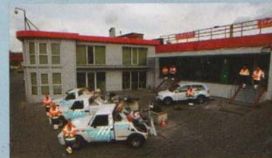
A droite, derrière les vitres blindées, le nouveau central d'appels qui fait office d'accueil clientèle.
